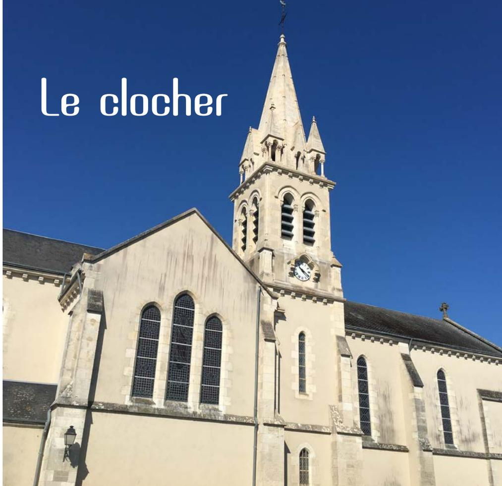
**Notre clocher d'Epieds a subi quelques travaux ces derniers mois. On a restauré les abat-sons. Un abat-son, c'est un ensemble de lames de bois inclinées et recouvertes de zinc dont on garnit les ouvertures des clochers, pour renvoyer vers le sol, le son des cloches. Notre clocher en compte 32 (8 par face).**
