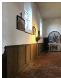
Réfection de la boiserie côté autel de la Vierge
